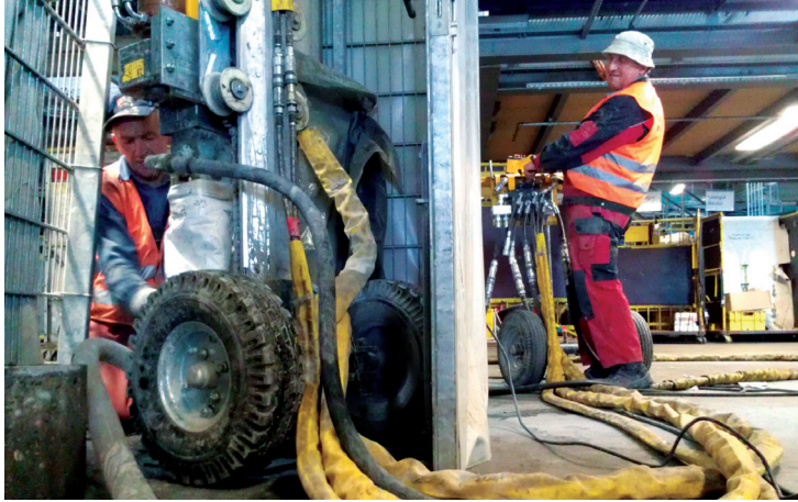
Pfahlerstellung mit kleinstem Gerät auf engstem Raum
