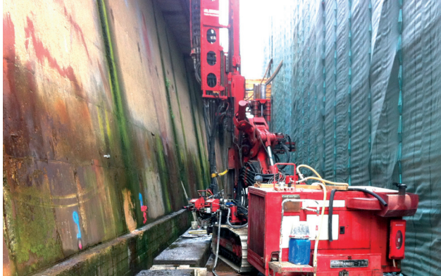
Pfahlherstellung unter stark eingegrenzten Platzverhältnissen
