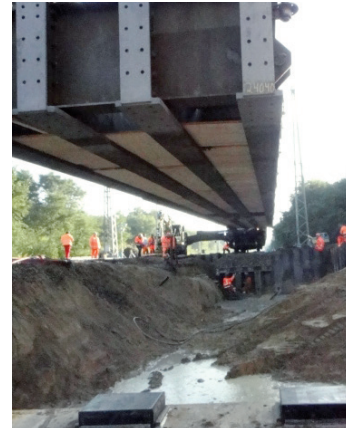
Einsetzen der Brücke
