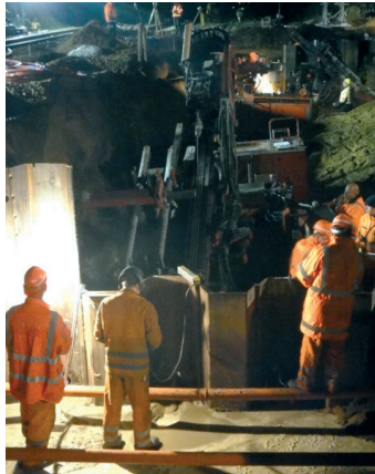
Baustellensituation in der Nacht
