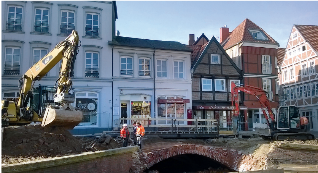
Blick auf die Bestandsgebäude und die alte Brücke
